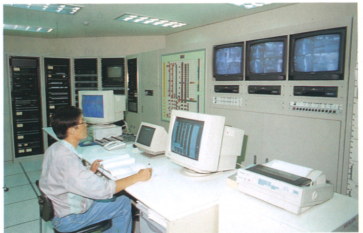
지하 1층 방재센터
