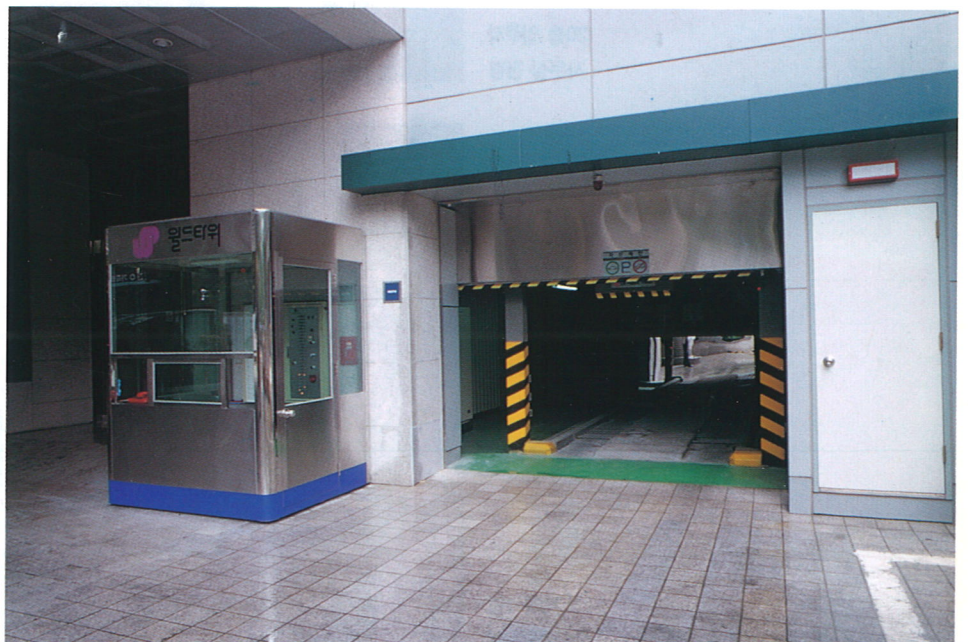
주차타워/지하 주차장외에 별도의 주차타워(50대)를 설치함으로써 입주사에게 충분한 주차공간을 제공해주고 있다.
