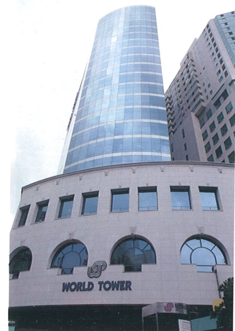
북동측 전경/건물 부출입구 전경으로 기단부인 저층부는 화강석으로, 고층부는 All Glass로 처리했다.
